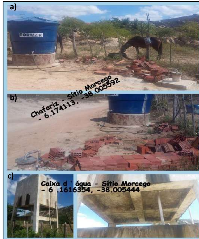
Figura 3.18 – a) Chafariz; b) bomba que capta água do poço tubular e c) caixa d’água do Sítio Morcego.
