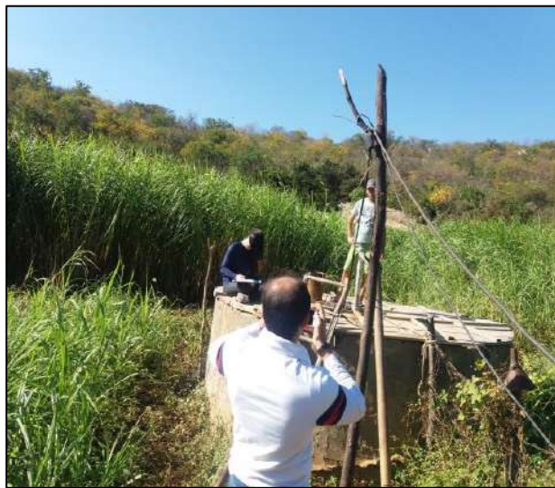
Figura 3.13 – Poço que abastece o Sítio Boa Vista.
