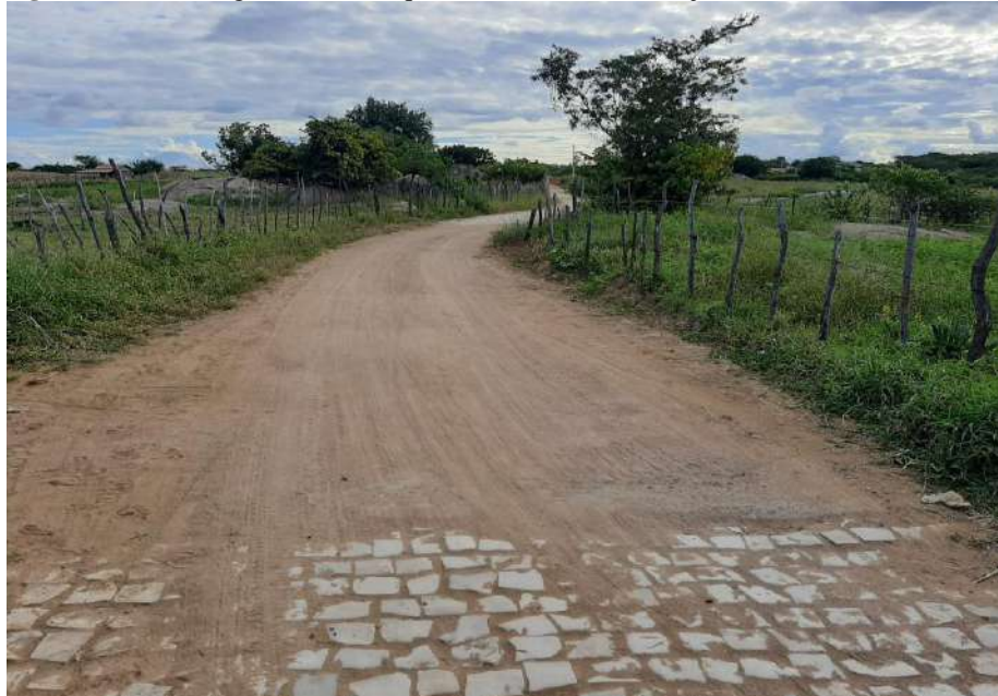
Figura 3.45 - Passagem molhada que dá acesso ao Sítio Lajes, em Serrinha dos Pintos.
